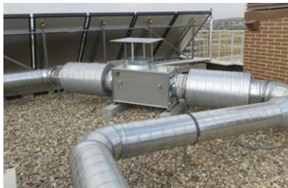
Si la red de ventilación no es estanca al aire, las fugas deben compensarse por un caudal importante a nivel de maquinaria.
